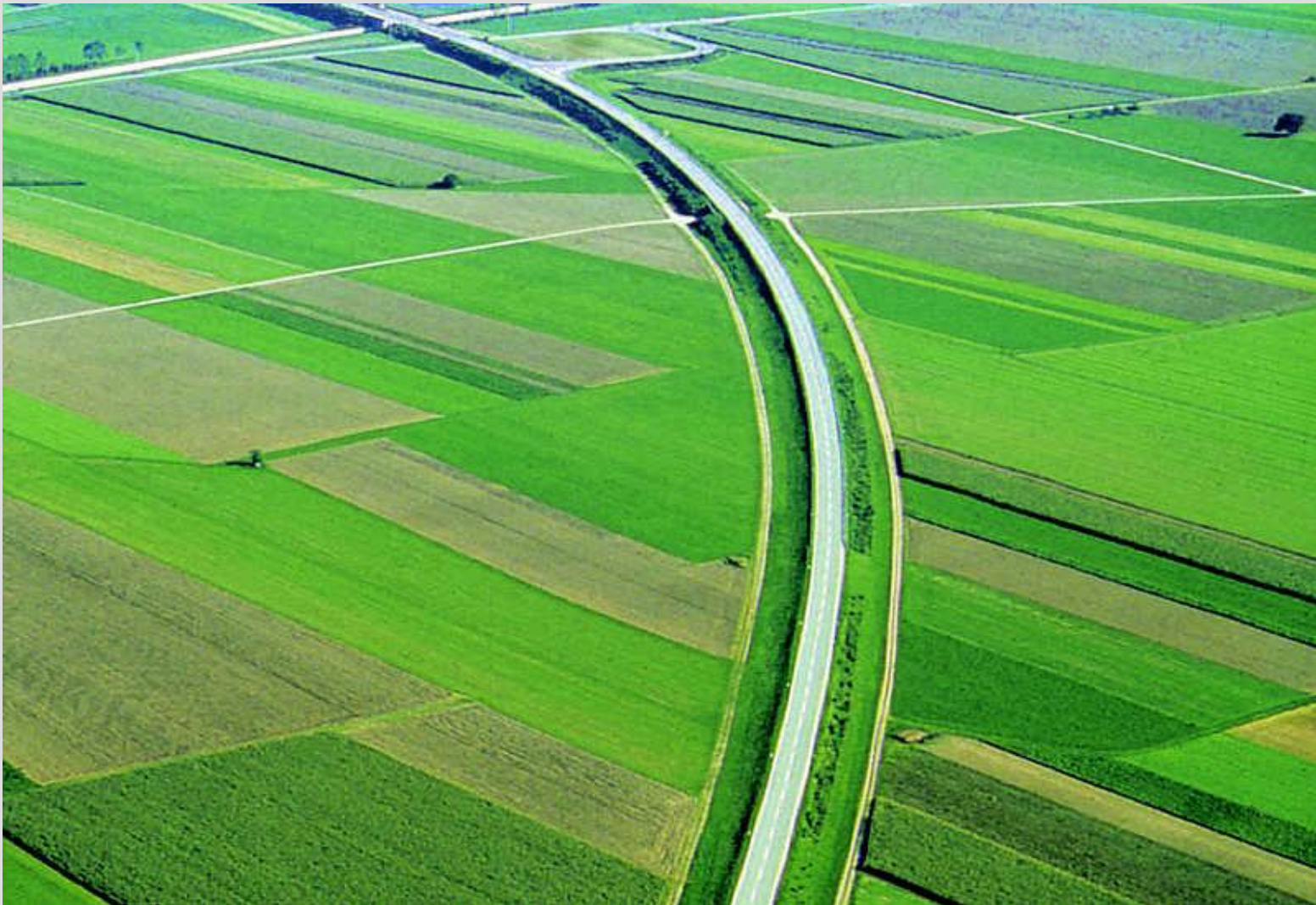
Umsetzung einer Großbaumaßnahme ohne Flurneuordnung
